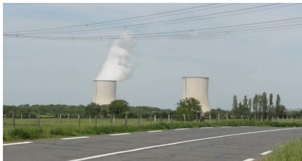
Centrale nucléaire de Civaux (Source : INGEROP)
